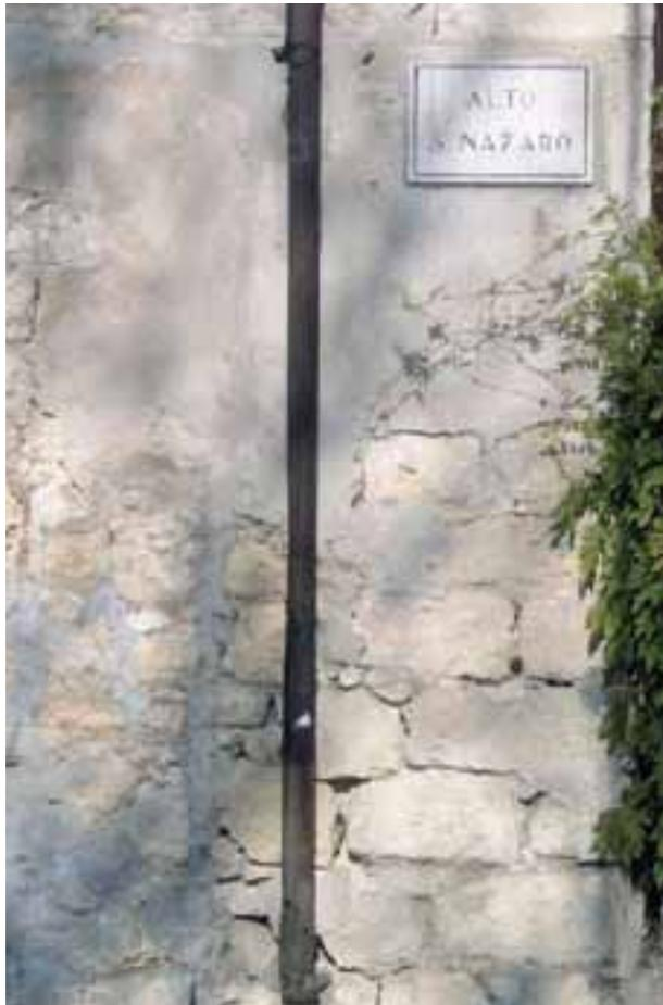
Il degrado dell'intonaco mette in luce la tessitura muraria degli edifici: grossi conci lapidei squadrati a definizione delle angolate e pietre sbazzate di media e piccola pezzatura per l'apparecchiatura muraria
